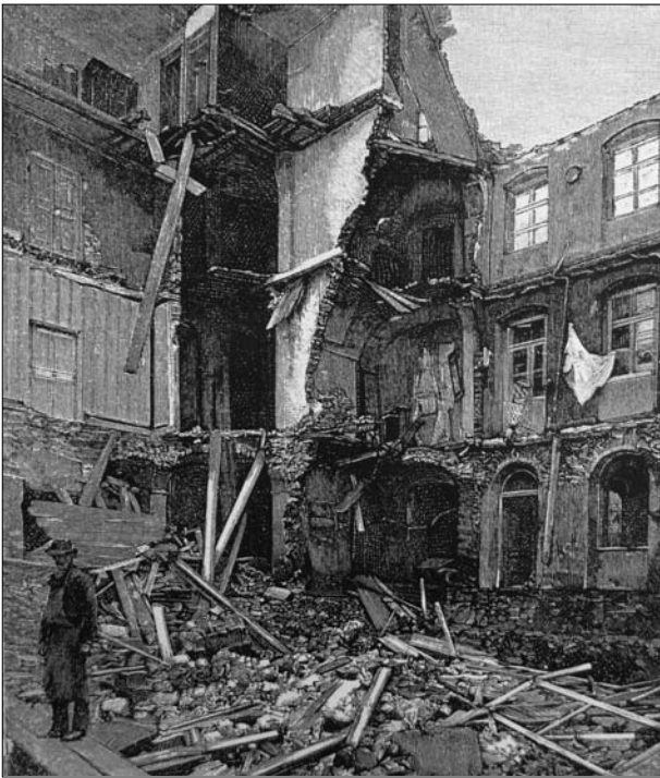
Fig. 13: The destroyed „Kaffeebaum“ house in Carlsbad after the flood of November 1890 (Collection of M. Deutsch)
