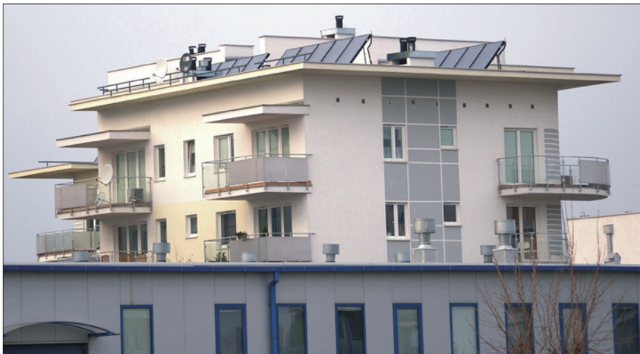
Fig. 4: A multi-family building with solar collectors managed by Spółdzielnia Mieszkaniowa “Budowlani” in Bydgoszcz (Kujawsko-Pomorskie Voivodship). Source: author
