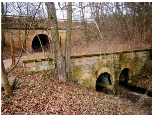
Technická památka – dvoupatrový most překlenuje potok Vrbovec a polní cestu. Most vznikl během prací na plánované dálnici Vídeň – Vratislav ve 40. letech 20. století (KK)
